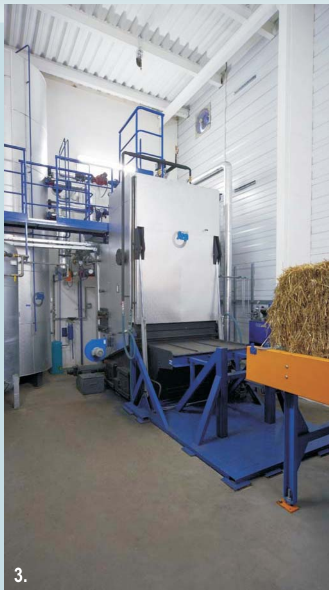
3. Так выглядит одна из демонстрационных котельных – в компании Step TRUTNOV a.s. – для сжигания целых тюков соломы, сена, льна, прессованного картона и т.д. (в процессе испытаний постоянно осуществлялся контроль уровня выбросов вредных веществ).
